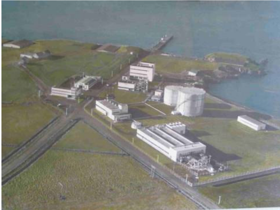
Mynd 4. Áburðarverksmiðjan í Gufunesi 1966, gamli bærinn stendur enn fyrir vestan verksmiðjuna. 24
